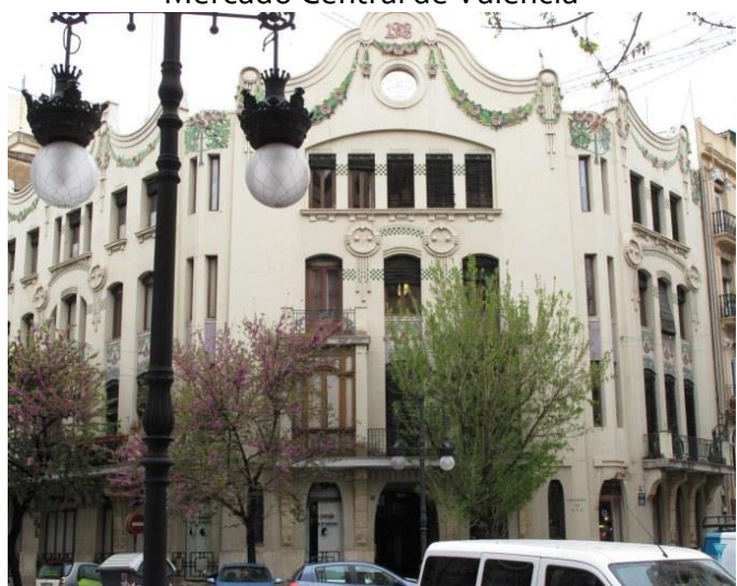
Casa Ferrer, modernista año 1.908 Valencia Fachada lateral a la calle Pizarro.
